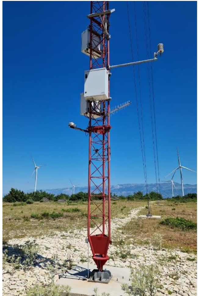
Slika 6-3 Mjerni stup (lijevo) i lokacija mjerne i registracijske opreme u donjem dijelu stupa (desno)
